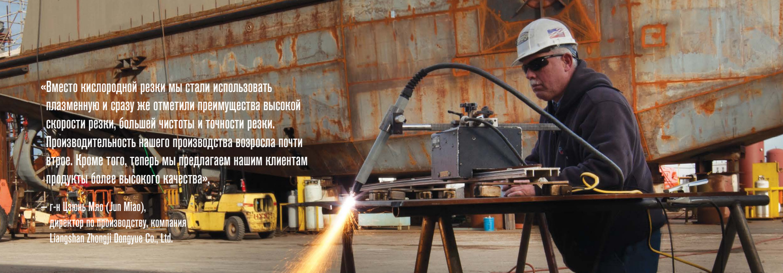
Резка и строжка по направляющей
